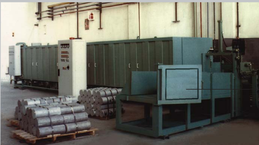
Horno de calentamiento para extrusión de billets de aluminio. Avance por empuje Forno de aquecimento para extrusão de tarugos de alumínio. Avance por empurre
