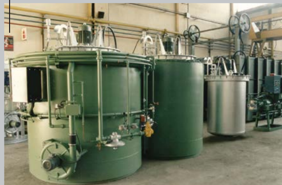
Instalación de pote para recocido bajo atmósfera Instalando de pote para recozimento sob atmosfera
