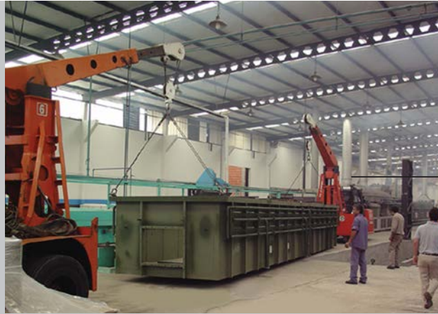
Instalaciones y montajes Instalação e montagem
